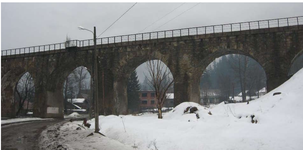
Wiadukt kolejowy w Worochcie
